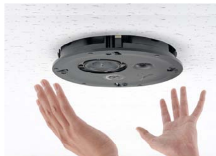
アンチドロップタブを用いた仮留め
